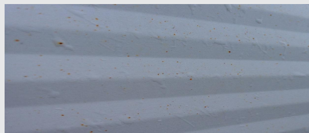
ROEST SCHADE OP PANELEN EN BEPLATING
